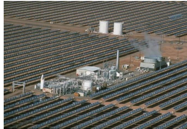
Solar Electric Generation Station – SEGS 354 MW (9 unidades), Deserto de Mojave, USA 0,65 km 2 /100MW, 2300 a 2900 kWh/m 2 .ano
