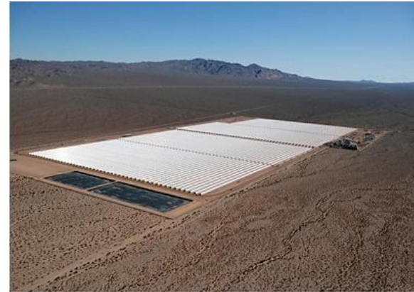
Nevada Solar One, 64 MW (construção).
